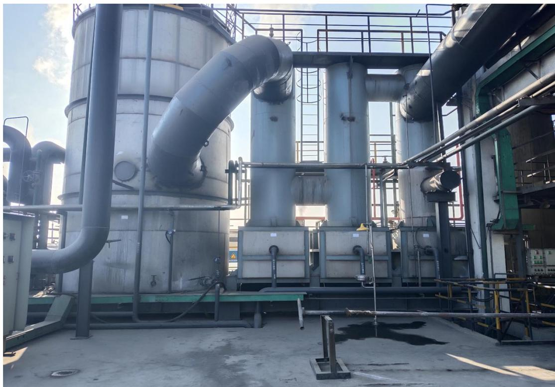
磷炉尾气回收净化系统（尾气收集碱水喷淋）
